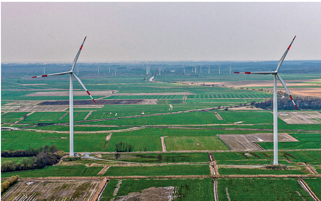
Abbildung 27: Windenergieanlagen (Quelle: RMS)
