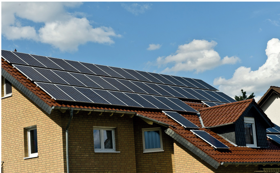
Abbildung 28: Photovoltaikanlage auf dem Dach eines Wohnhauses (Quelle: RMS)
